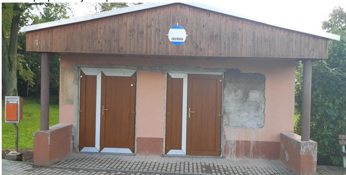
Pohled při probíhajících pracích
