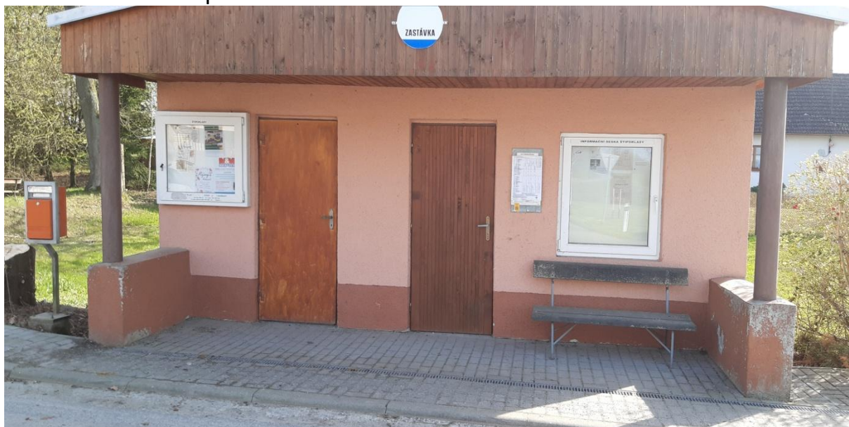
Pohled na čekárnu před rekonstrukcí
