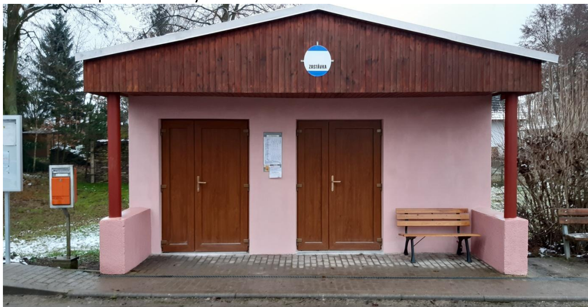
Dokončená oprava čekárny.
